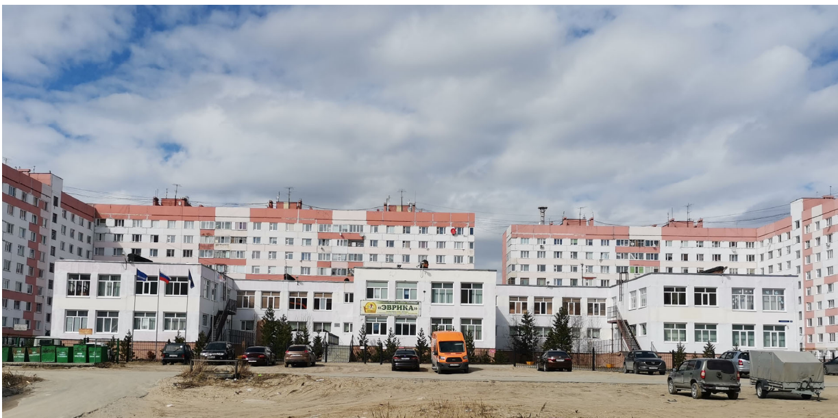
Общий вид с южной стороны
